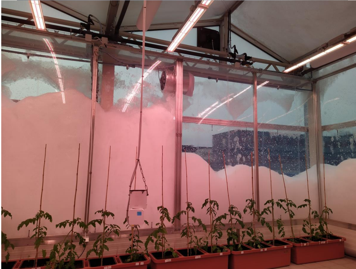
Bobleveksthus – isolert med såpebobler
