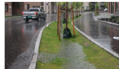
Bilde 1: Infiltrasjonsgrøft på Bispe i en gate med plass til større grønngrovt med plass til trær og nedløst et overvann for et senere bil i en trangere gate.
